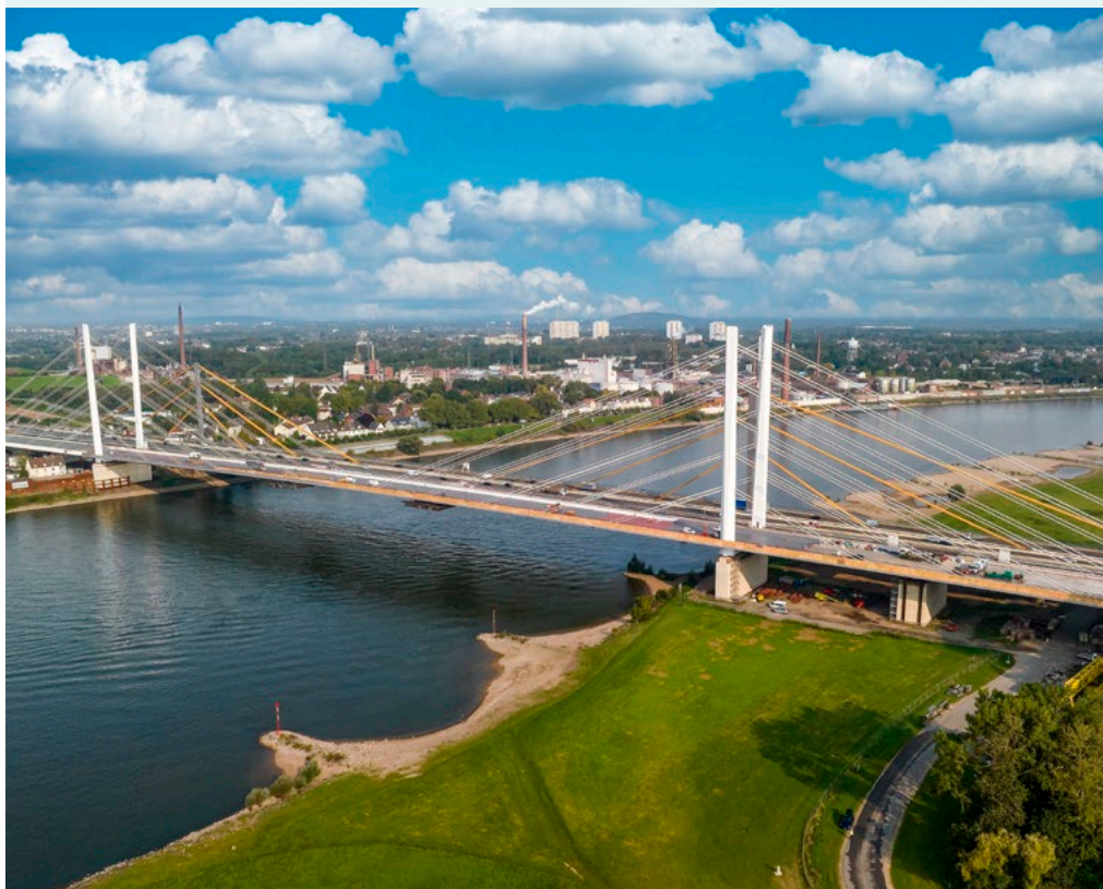
Die Rheinbrücke Neuenkamp in Duisburg wird aus zwei parallel verlaufenden Brückenteilen bestehen.
